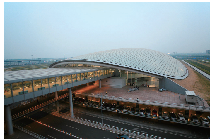
◆ 北京机场T3航站楼
